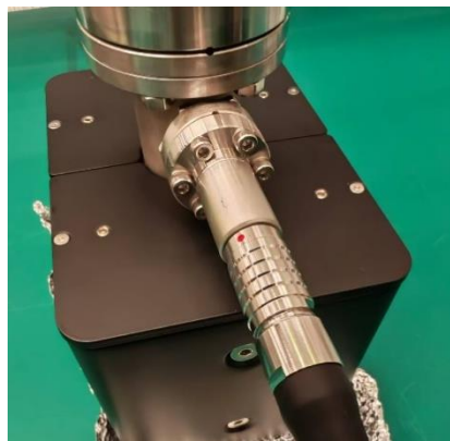
图4 高压电缆与离子泵连接
